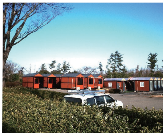
復旧工事施工者の専用プレハブ宿舎
